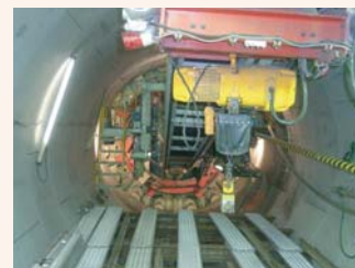
セグメント組立状況
